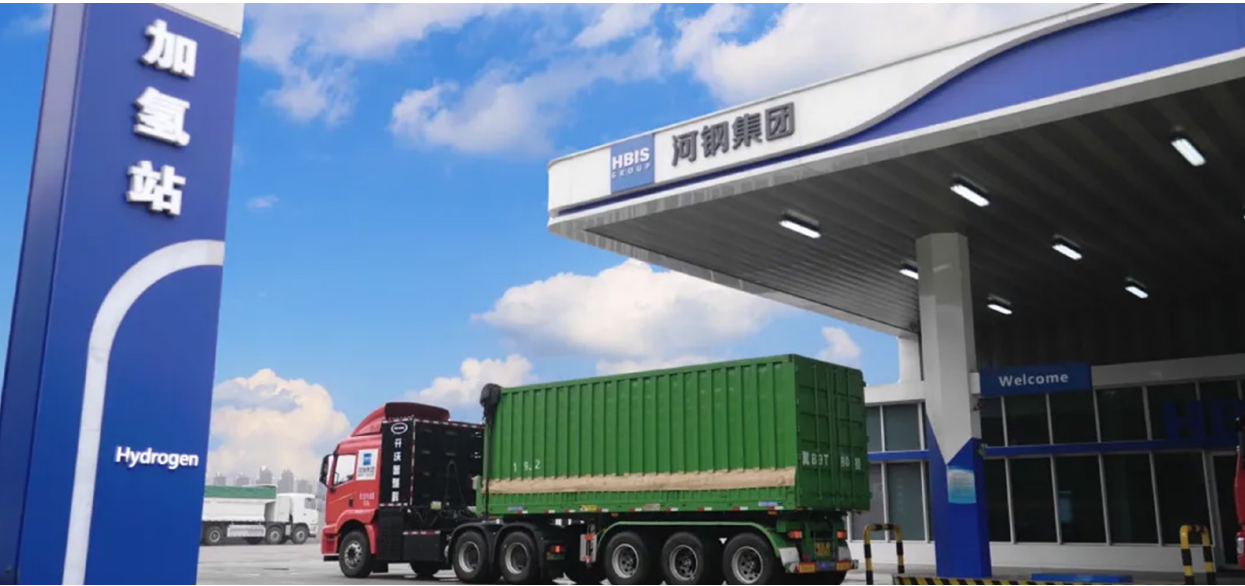
固定式加氢站
